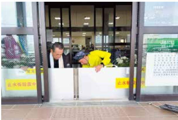
▲田主丸支店入り口に止水板を取り付ける職員ら
