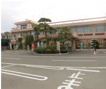
▲浮羽支店(浮羽地区)
